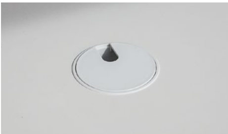
Acceso cableado "U" de Ø80mm.
